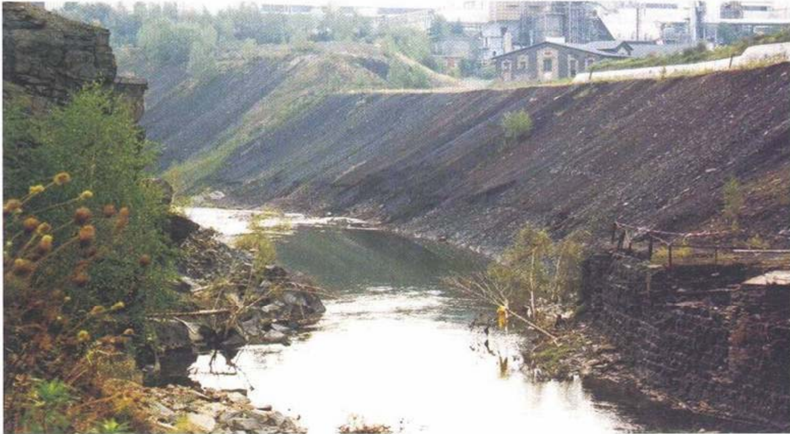
Bild 5: Durchfluss der Freiberger Mulde am Altlasten-Standort Freiberg-Muldenhütten; rechts Halden der ehemaligen Arsenhütte mit Hochwasserlinie (Foto Rank 07.09.2002)
