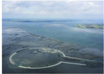
Sand nourishment Galgeplaat
